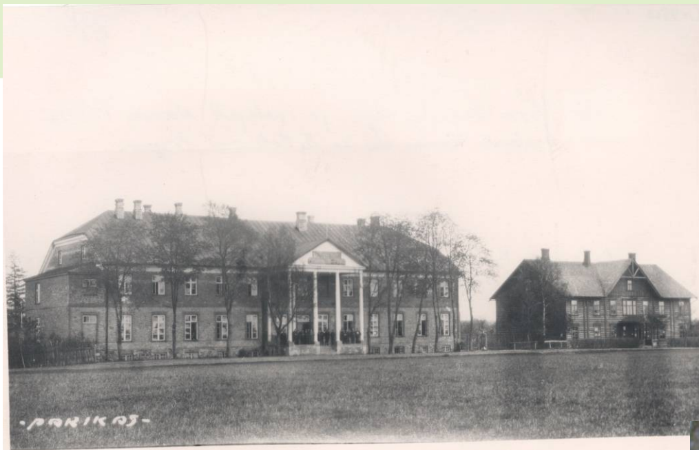
Здание эстонской школы Александра II-го в Лифляндии построенное в 1887–1888 гг.
