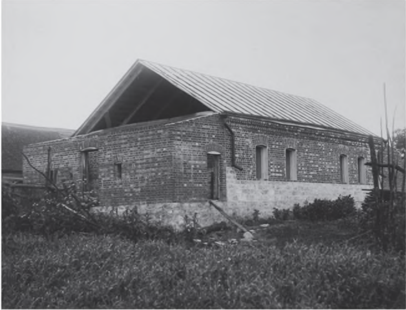
Телятинки, новый дом в стадии строительства, так и не завершенного, 1910-е гг.
