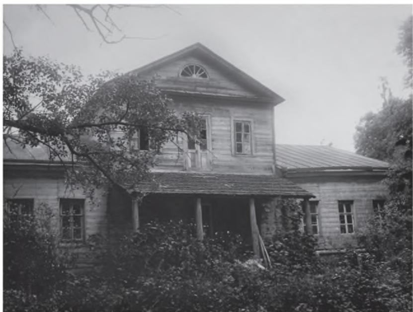
Усадебный дом, вид со стороны парка, 1910-е гг.
