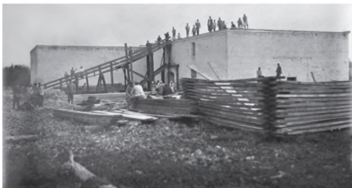
Моховое. Начало строительства зерноочистительной фабрики, 1923 г.
