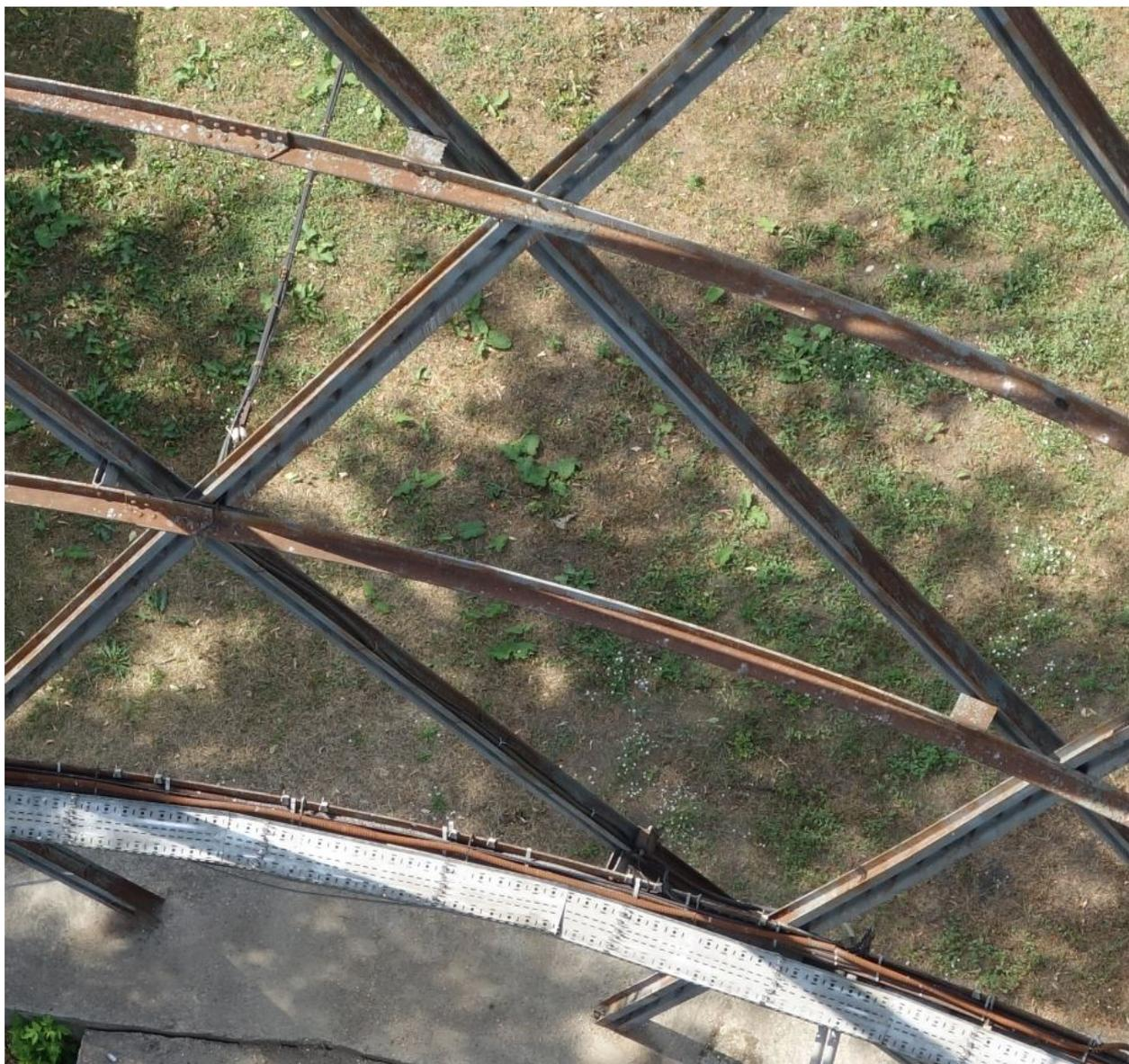
Рисунок 2.14 — Нижняя часть 1 секции башни: для крепления второго промежуточного кольца используются как скобы, так и коротыши
