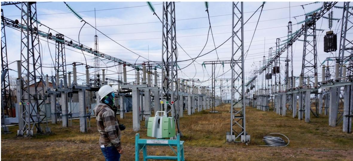
Рисунок 3.21 — Лазерное сканирование электрической подстанции.
