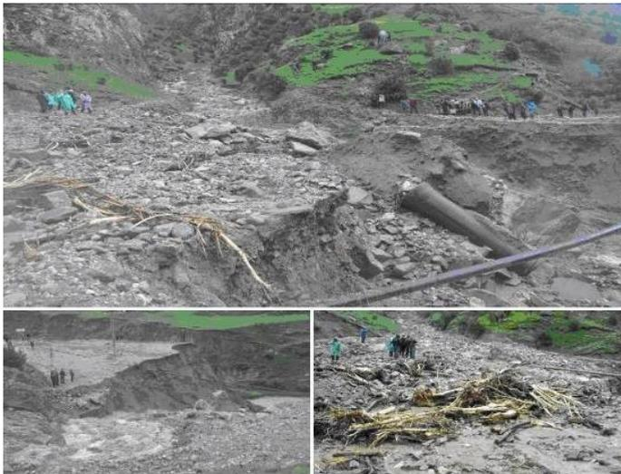
Рис. 4. Размытый селевым потоком (по ручью без названия) участок автодороги Урвань-Уштулу при въезде в село Верхняя Балкария
