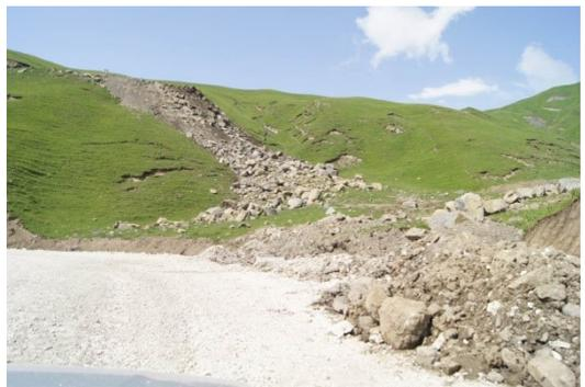
Рис. 9. Горная часть. Проявление оползней на участке строительства автодороги
