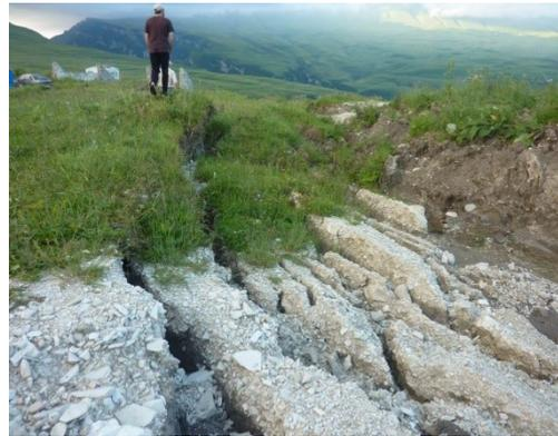
Рис. 3. Горная часть. Наблюдается разрушение дороги вследствие развития оползневого процесса
