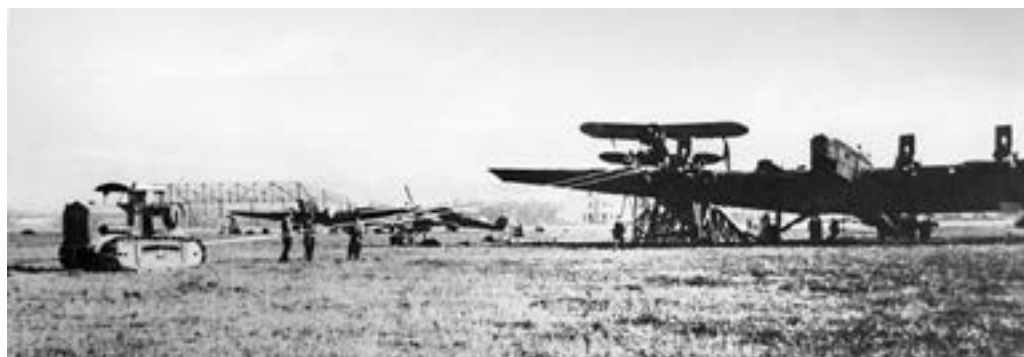
Установка истребителя И-5 на ТБ-3 с помощью трактора
