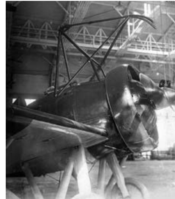
Устройство для подцепки на истребителе И-З
