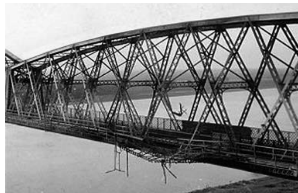
Повреждённый атакой СПБ Чернаводский мост через Дунай
