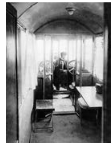
Вид на кабину из пассажирского отсека
