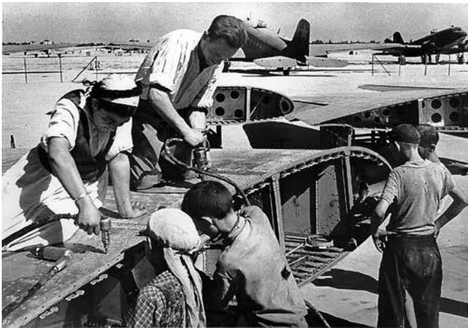
**Рис. 4.5.** После эвакуации в Ташкент первые Ли-2 изготавливали под открытым небом
