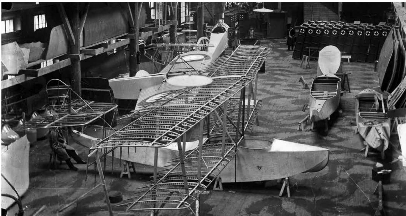
Рис. 1.7. Изготовление летающих лодок М-5
