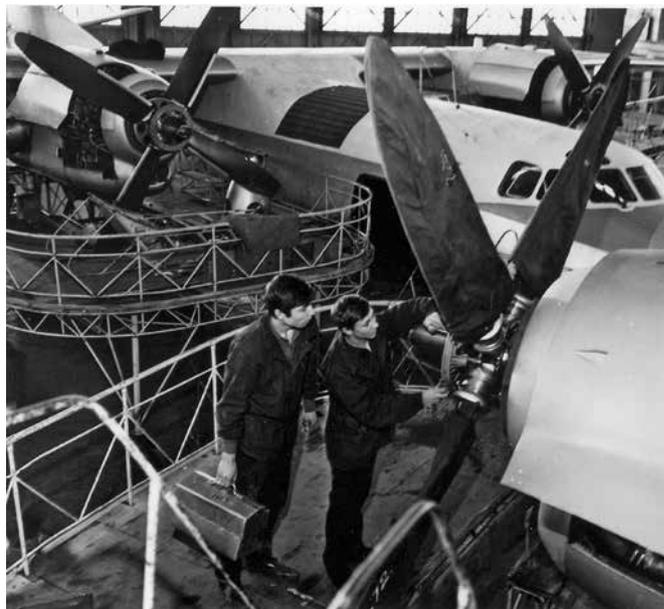
Рис. 6.2. Сборка Ан-24 на заводе в Улан-Удэ. 1967 г.
