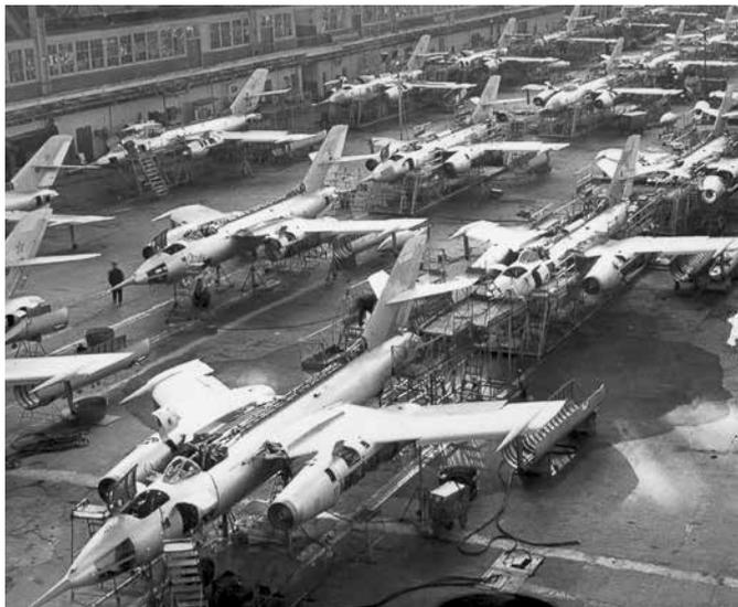
**Рис. 5.16. Поточное производство Як-28П на заводе в Иркутске**
