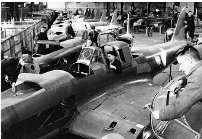
**Рис. 4.8. Поточное производство штурмовиков Ил-2 на заводе в Куйбышеве**
