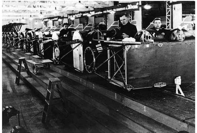
Рис. 3.2. Конвейерная сборка самолетов У-2 на заводе № 23
