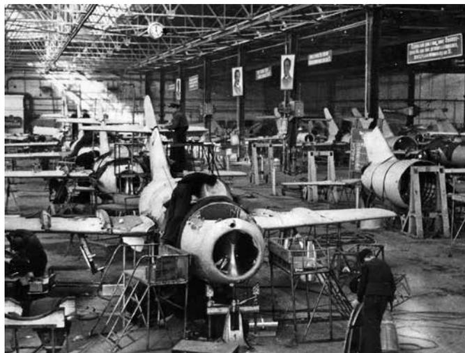
Рис. 5.9. Поточная сборка МиГ-15 на заводе № 1.
