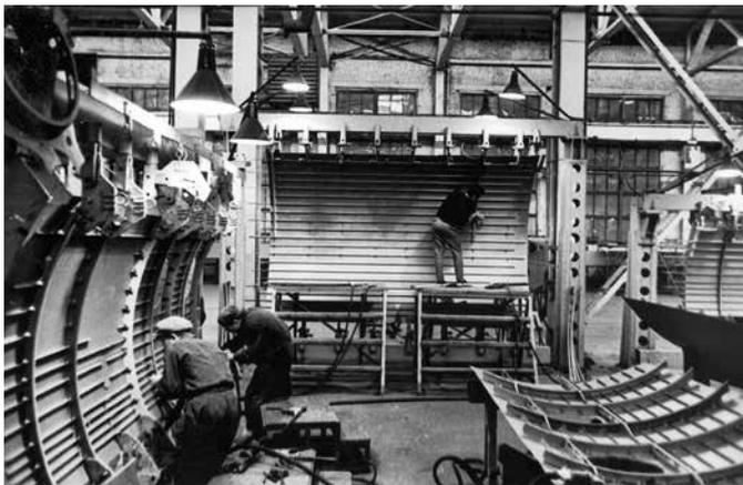
Рис. 5.14. Сборка панелей самолета Ан-24
