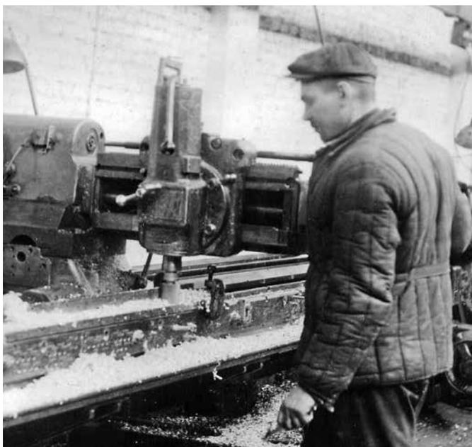
Рис. 5.8. Фрезерование полок лонжерона. 1949 г.
