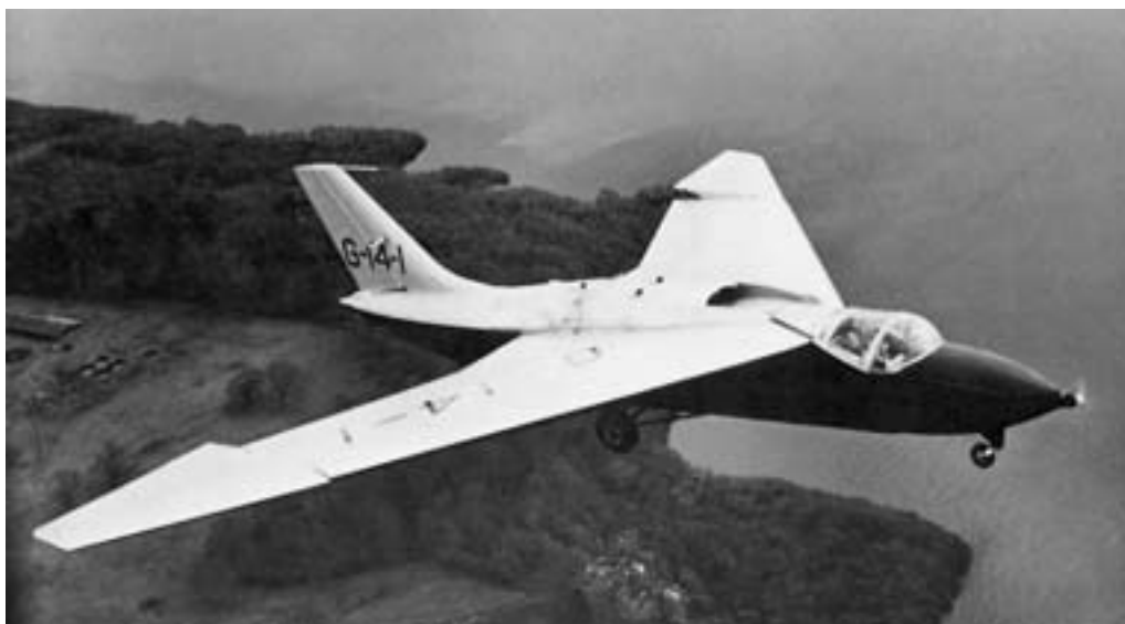
Шорт "Шерна" с изоклиническим крылом.
