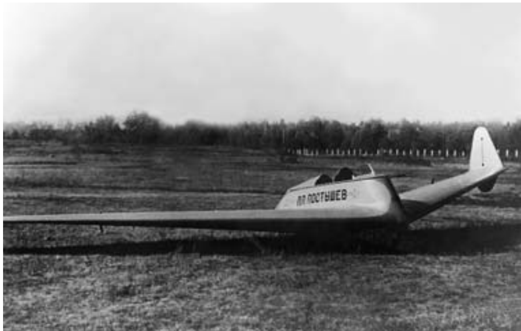
"П.П.Постышев" — первый в нашей стране бесхвостый планер, на котором можно было выполнять фигуры высшего пилотажа.
