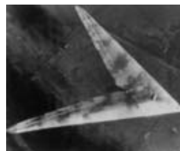
Планер Хортен Но.XIII отличался необычно большой стреловидностью крыла.
