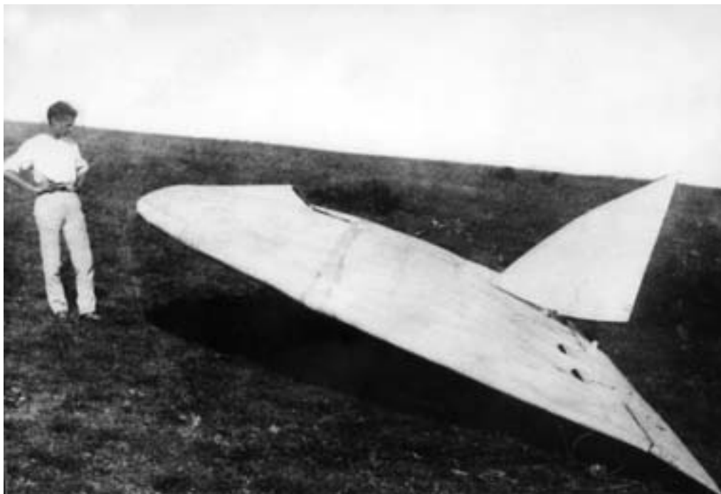
Планер БИЧ-2 имел увеличенный размах крыла и вертикальное оперение.
