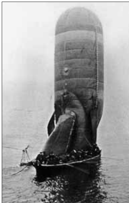
Буксировка севшего на воду аэростата к крейсеру «Россия». Вода, попавшая в рулевой мешок, удерживает аэростат в вертикальном положении
