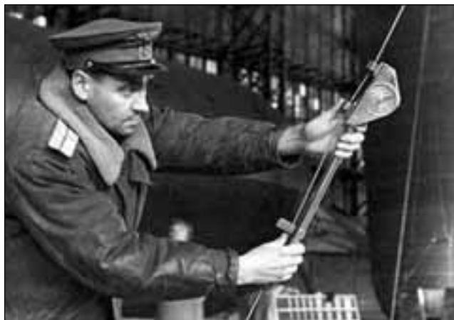
Конструктор моторизованного аэростата «Мальши» и дирижаблей «Победа» и «Патриот» Борис Арнольдovich Гарф проверяет динамометром натяжение троса
