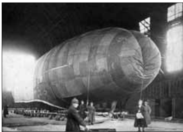
Наполнение оболочки дирижабля «VI Октябрь» в эллинге
