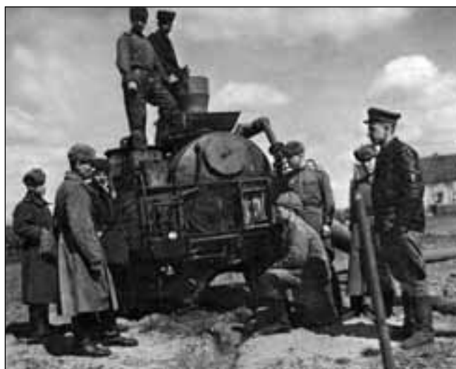
Получение водорода. Справа — помощник командира по технической части Н. Жгун
