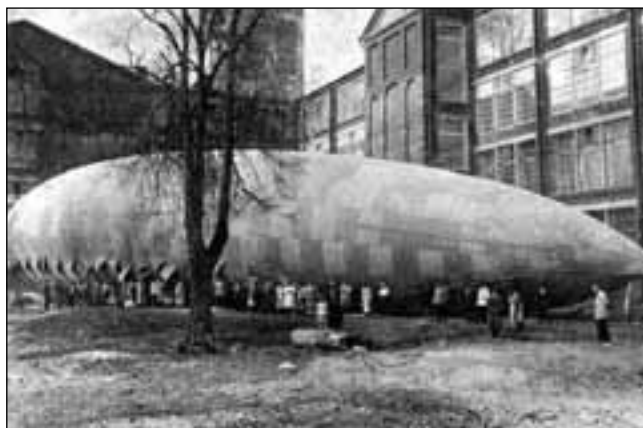
Продувка оболочки дирижабля «Московский Химик-резинщик» на заводе «Каучук» в Москве. 1924 г.
