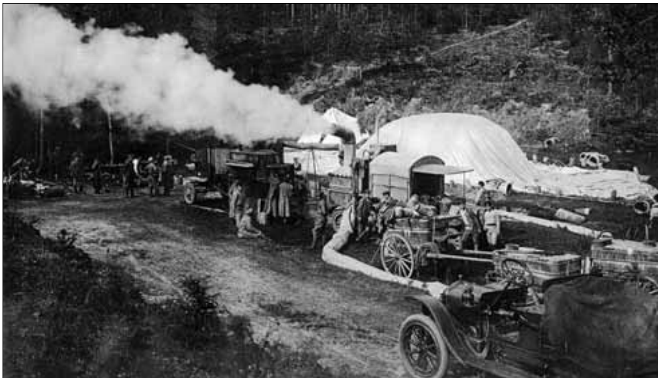
Силиколевые газодобывательные установки фирмы «Оксилит» продолжали применяться в годы Гражданской войны и некоторое время после неё. Автомобильная установка «Оксилит» на стрельбах под Лугой в начале 1920-х годов
