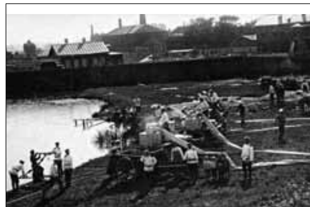
Получение водорода двуколочными алюминиево-щёлочными газодобывательными аппаратами. Солдаты качают ручным насосом воду в генератор и холодильники
