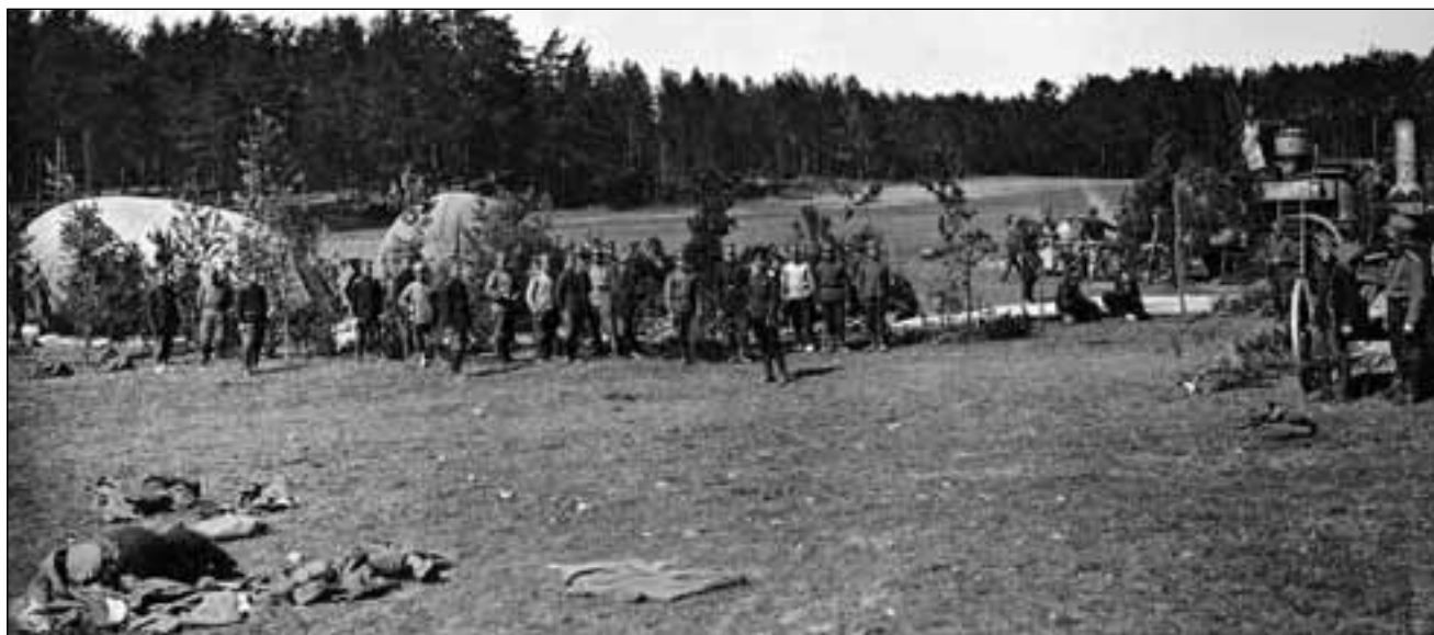
Наполнение аэростатов от силиколевой газодобывательной установки. Двинск, 1916 г.
