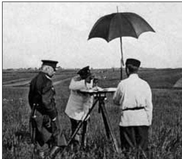
Измерения с помощью нефоскопа М.М. Поморцева
