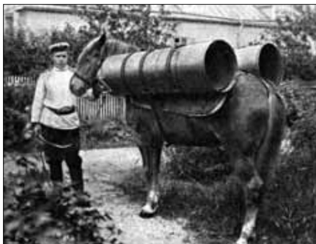
Вьюк с частью алюминиево-щёлочного газодобывательного аппарата
