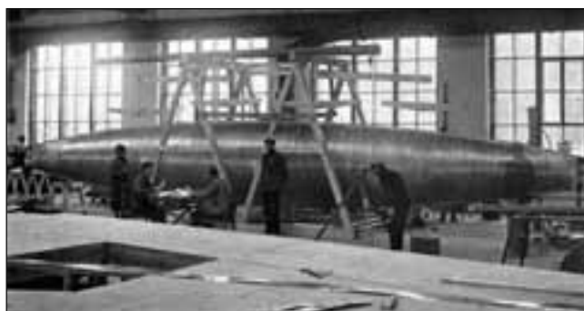
Статические испытания модели ЦМ-1. 1934 г.
