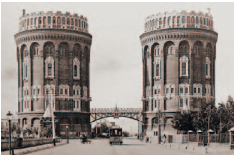
Рис. 17. Крестовские водонапорные башни. Фото конца XIX в. (источник: Московский водопровод. Московский архитектор М.К. Геппелер. [Электронный ресурс] URL: http://geppener.ru )
