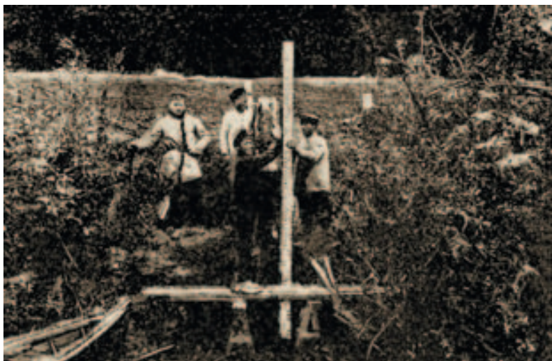
Рис. 54. Забивка свай на посту Троице-Лыково (Кравченко И.П. Исследование реки Москвы и ее описание. М.: Транспечать НКПС, 1930. С. 28)
